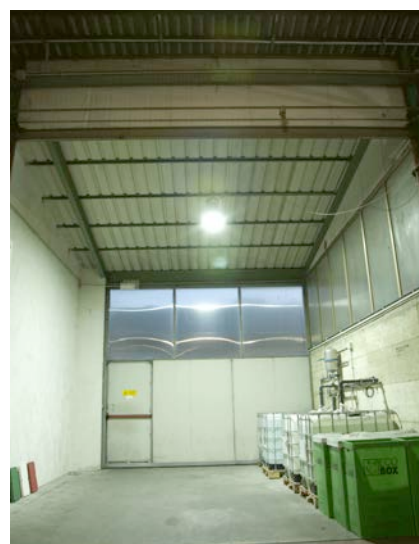
Capannone illuminato con lampade a LED. L'illuminamento, a parità di flusso luminoso è più gradevole e le ombre meno accentuate.
